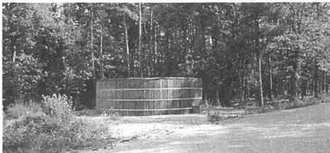
Exemple d'une citerne bardée de bois
